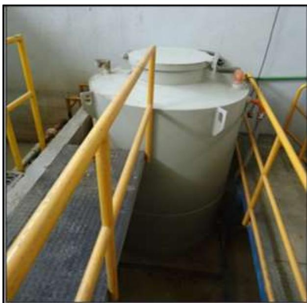
Figura 4.8 – Tanque Adensador. (Empresa em estudo, 2015).
