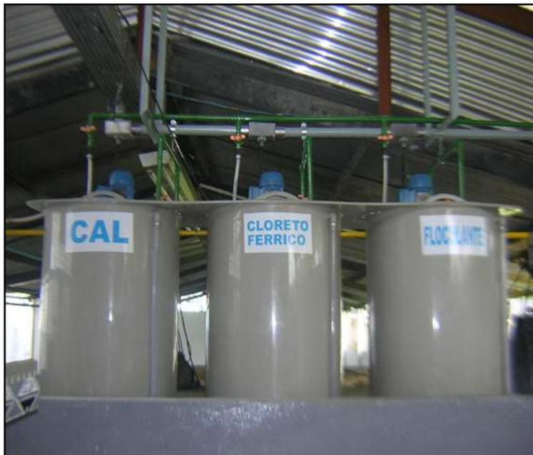
Figura 4.6 – Tanque de Preparação. (Empresa em estudo, 2015).
